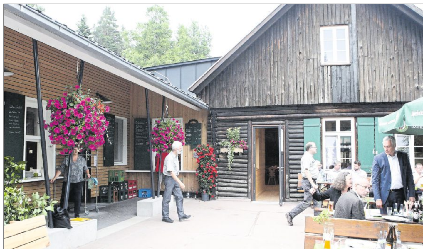
INSGESAMT 309 SITZPLÄTZE drinnen oder unter freiem Himmel bietet die Grünhütte künftig für ihre Besucher. Im Innenraum wurde die Gaststube mit Weißtannenholz ausgebaut. Fotos: jk
