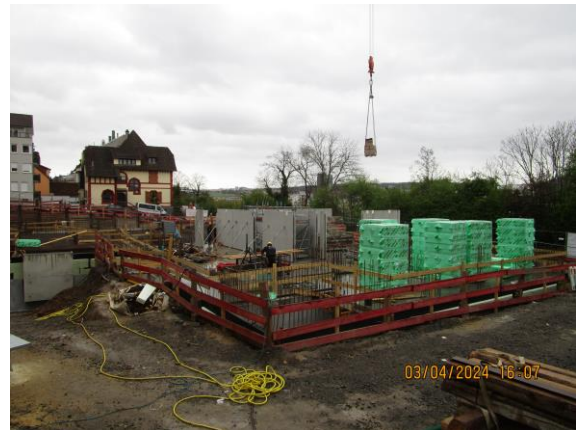
kurz danach stehen schon die Wände drauf
