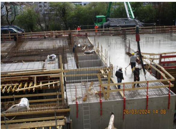
Die erste Decke wird betoniert, und ....
